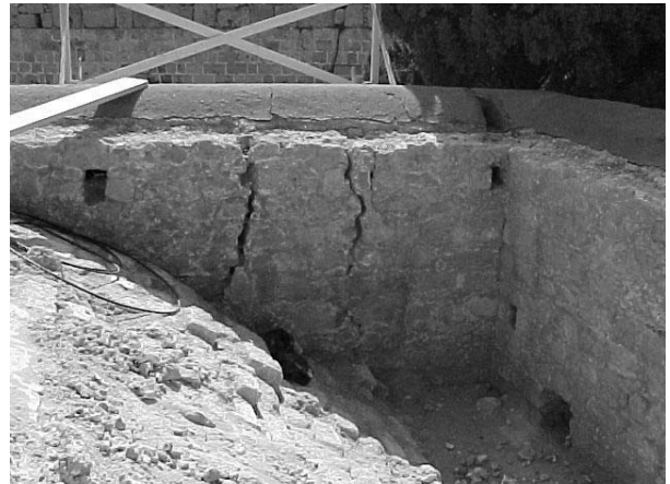
Σχήμα 3: Γενική άποψη του Θόλου (α,β). Εμφανείς ρηγματώσεις στον ανατολικό τοίχο (γ), εσωτερικά (δ) και στο επίπεδο του θόλου (ε,στ)
