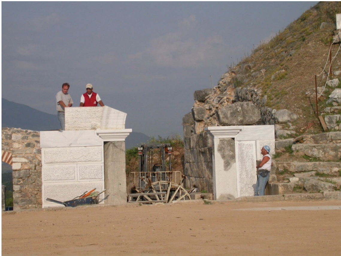
Φωτογραφία 9: Η έναρξη κατασκευής του τόξου. Ανατολική όψη. Αριστερά φαίνεται ο νότιος πεσσός
