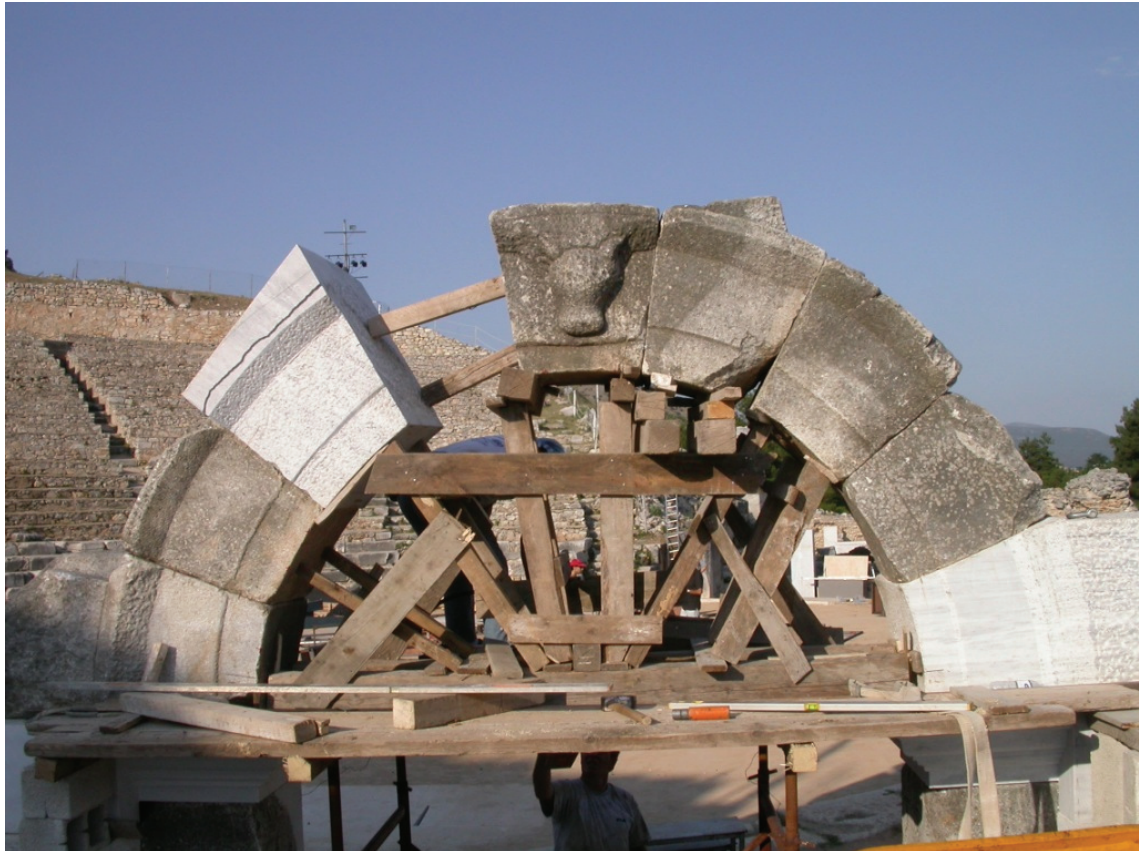
Φωτογραφία 10: Η εξέλιξη της κατασκευής του τόξου. Δυτική όψη
