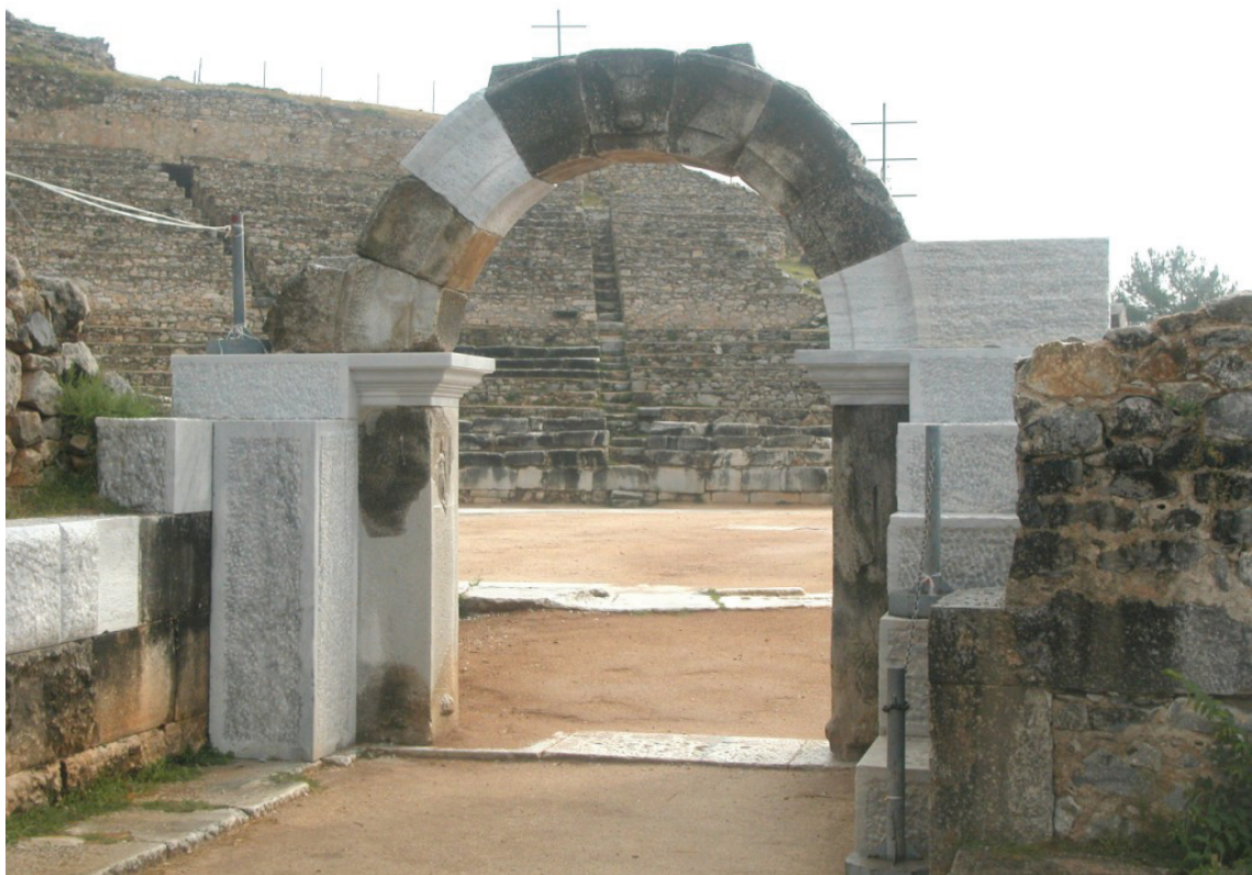
Φωτογραφία 12: Ολοκλήρωση του τόξου. Δυτική όψη
