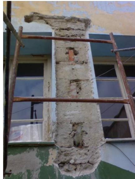
Εικ. 15 Δόμηση πεσσού με μικτό σύστημα φυσικών λίθων, τσιμεντολίθων και παρεμβολή οπτοπλίνθων
