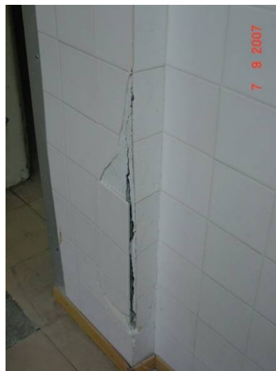
Εικ. 35 Διόγκωση και αποφλοίωση σκυροδέματος υποστυλώματος ισογείου της πτέρυγας Β λόγω οξείδωσης των οπλισμών του
