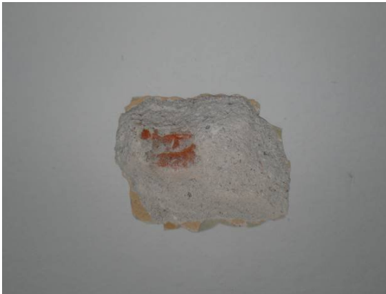
Εικ. 12 Διερευνητική τομή στη μοναδική εσωτερική φέρουσα τοιχοποιία της πτέρυγας Α. Διαπιστώθηκε οπτοπλινθοδομή πλήρων πλίνθων
