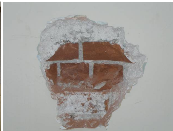
Εικ. 17 Φέρουσα πλινθοδομή πλήρων πλίνθων. Διακρίνεται η πλέξη των πλίνθων
