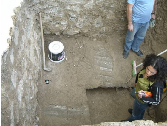
Εικ. 10 Αποκάλυψη περυγίου θεμελίωσης
