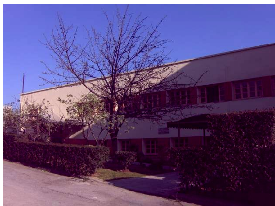
Εικ. 2 Τμήμα της κύριας όψης της διώροφης πτέρυγας Α
