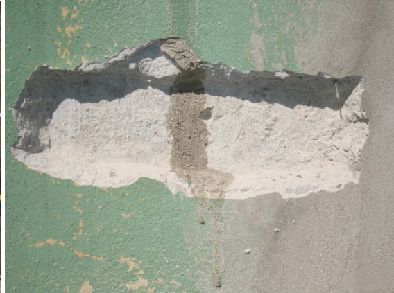
Εικ. 11 Εξωτερική περίμετρος ισογείου της πτέρυγας Α. Διαπιστώθηκε οπλισμένο σκυρόδεμα
