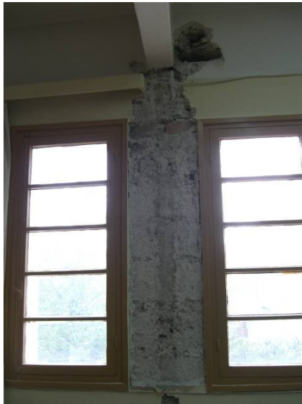
Εικ. 14 Δόμηση πεσσού με μικτό σύστημα φυσικών λίθων και τσιμεντολίθων
