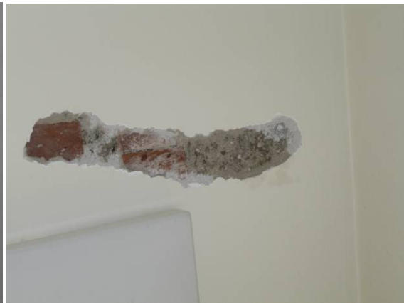
Εικ. 13 Διερεύνηση πλάκας με νευρώσεις. Διακρίνονται οι οπτόπλινθοι μεταξύ των νευρώσεων
