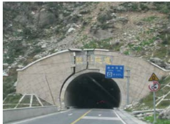
Σχήμα 1: Σεισμικές βλάβες σε γέφυρα (αριστερά) και σήραγγα (δεξιά) οπλισμένου σκυροδέματος του οδικού δικτύου της επαρχίας Sichuan στην Κίνα μετά τον ισχυρό σεισμό μεγέθους M_s=7.9 (Μάιος 2008)
