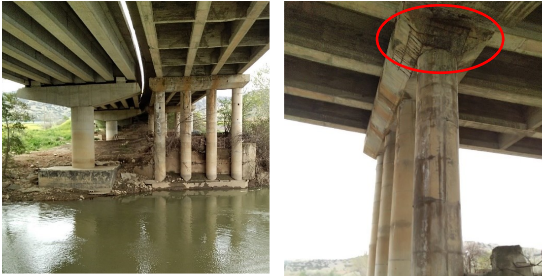
Σχήμα 3: Παλιός (με πολύστυλα βάθρα) και νέος (με μονόστυλα βάθρα) κλάδος της γέφυρας στην περιοχή της Φαρκαδόνας
